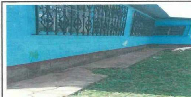
Foto 5: Se observa en la fotografía la demanda de repello y pintura de la pared del edificio tres.
